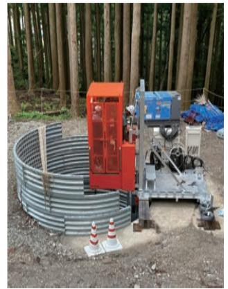
設置スペースは、階段型昇降設備の1/2。本体サイズだけでなく、レールや制御盤も省スペース設計なので、搬入口の小さな道路覆工下の立坑など狭い現場でも取付けが可能です。
